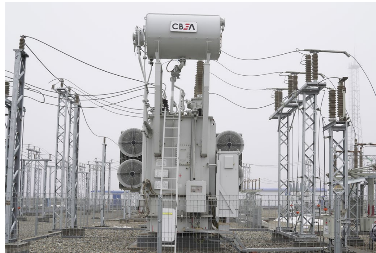
СТРОИТЕЛЬСТВО ПС 110/35 КВ «ДЖУРАКСКАЯ» ПО АРХИТЕКТУРЕ II ТИПА С ДВУМЯ СИЛОВЫМИ ТРАНСФОРМАТОРАМИ МОЩНОСТЬЮ НЕ МЕНЕЕ 62,9 МВА КАЖДЫЙ.
